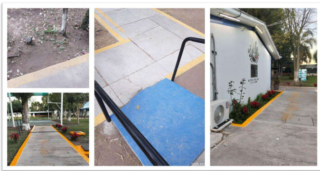
Ilustración 58. Balizamiento de banquetas.
