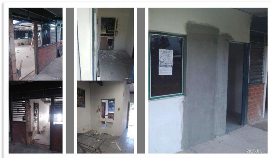
Ilustración 46. Mantenimiento a Sala de Juntas_01.
