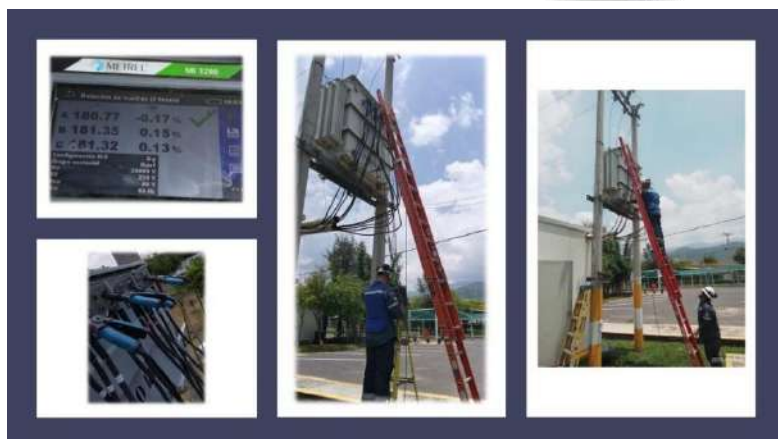
Ilustración 50. Mantenimiento a Transformadores.
