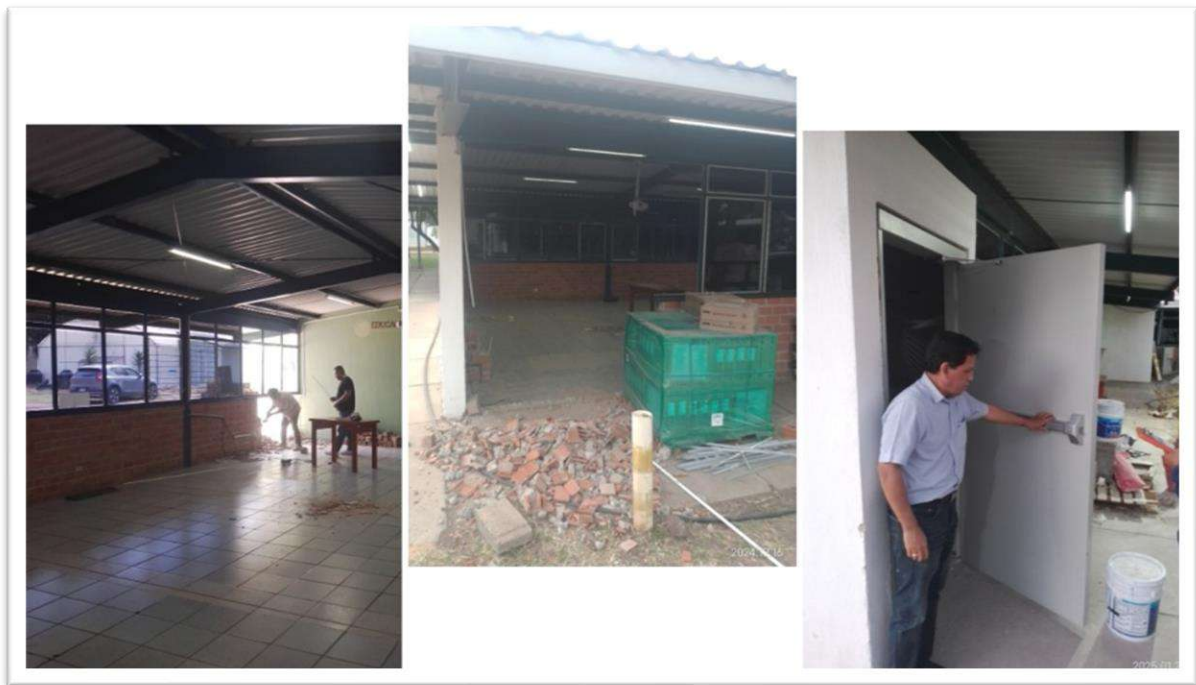
Ilustración 56. Instalación de Puerta de Emergencia en Sala de Juntas.
