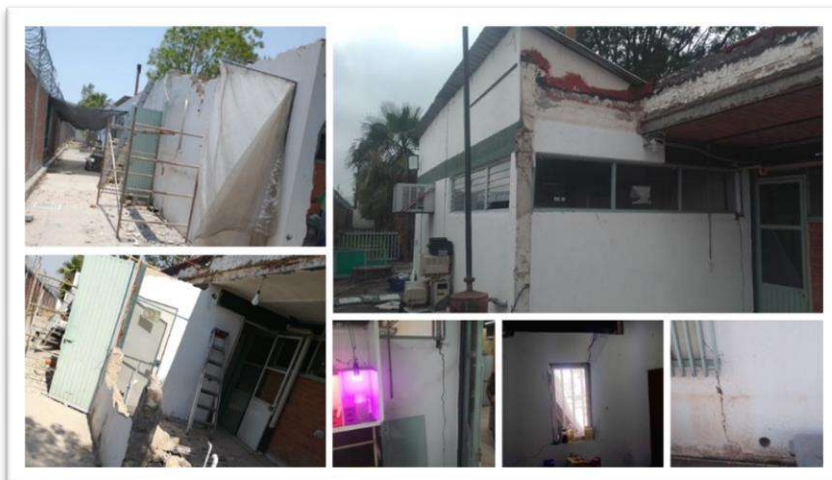
Ilustración 52. Demolición de Bóveda y Muros.
