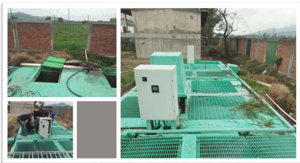
Ilustración 44. Mantenimiento a Planta Tratadora.
