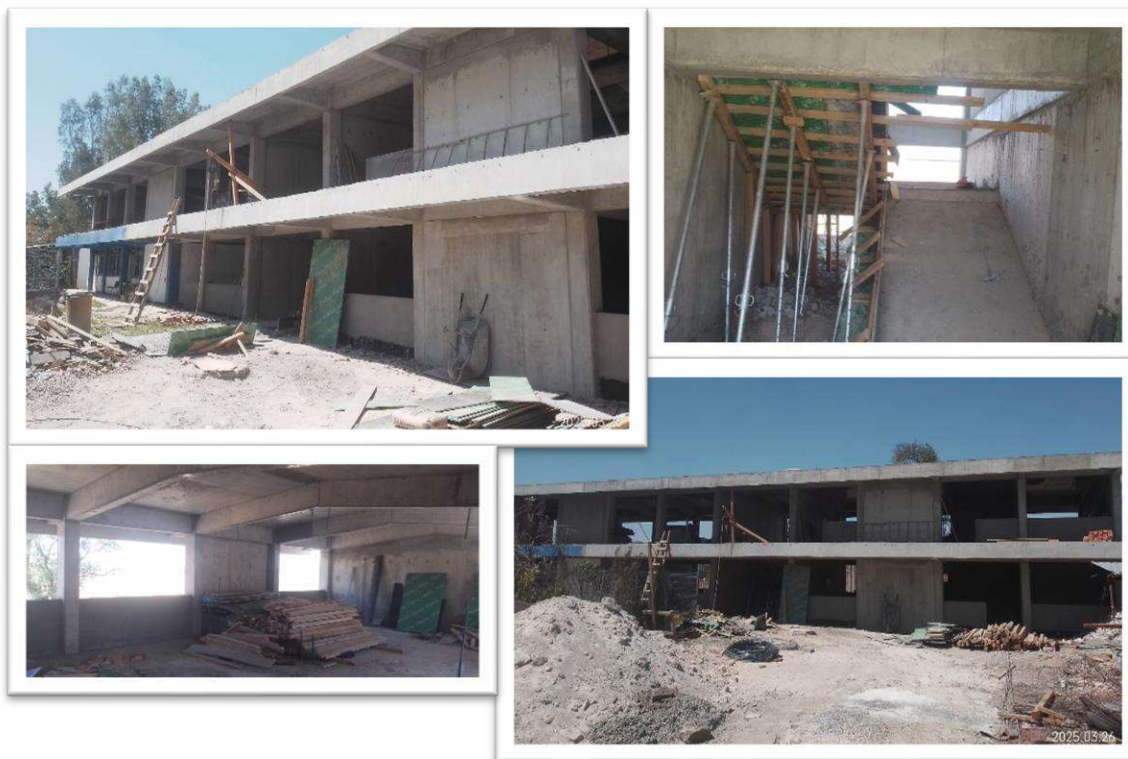
Ilustración 40. Construcción de Edificio Tipo U2-C.
